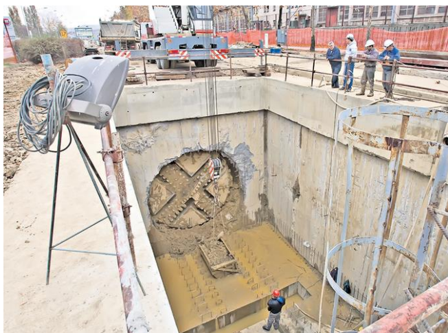
Слика 4.8. Колектор-интерцептор у Вишњици
