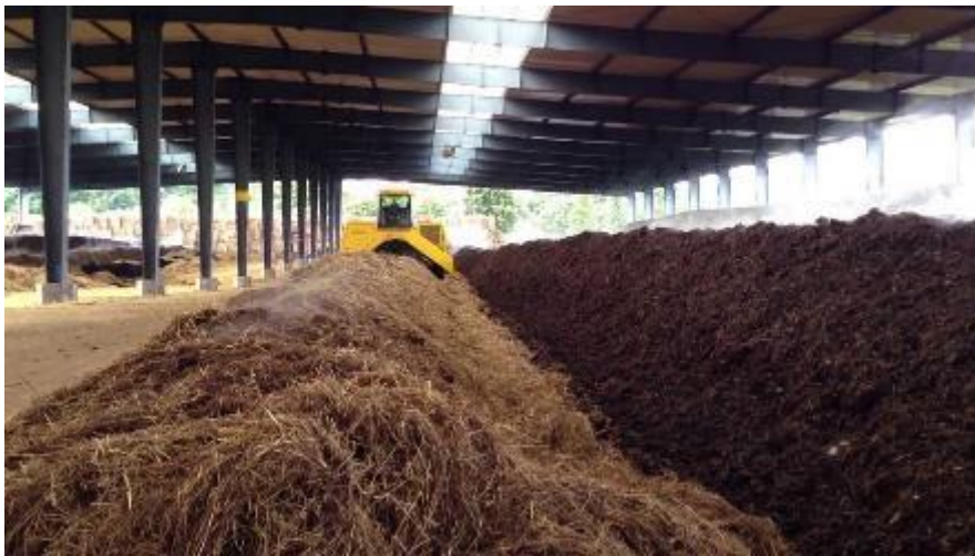
Слика 6.48. Компостирање зеленог отпада
